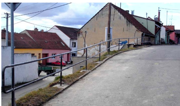
Nové zábradlí na ulici Starohorská
